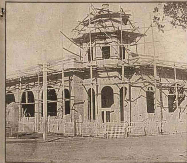
A foto da década de 30 mostra as obras de construção do Clube Congresso Lagunense. A elevação da Cúpula sobre o hall de entrada principal, merece destaque especial, e, assemelha-se ao antigo Banco Nacional do Comercio. O sistema construtivo é autoportante com tijolos maciços e o concreto armado já surge como elemento estruturante.
